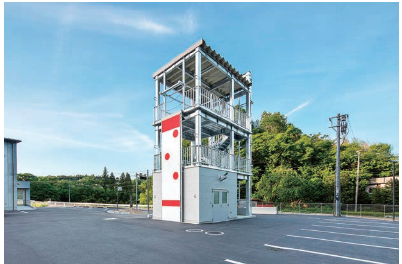
石川消防署訓練塔
